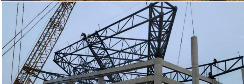
固定措施。项目施工过程中起重重量大，施工方案经专家论证全程采取400T履带吊施工。
