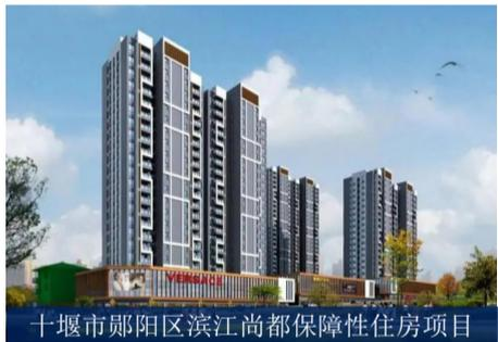
湖北华林杭萧参建的十堰市郧阳区滨江尚都保障性住房项目（EPC总承包）占地面积4.55万m<sup>2</sup>，总建筑面积14.13万m<sup>2</sup>，其中装配式钢结构建筑面积8.7万m<sup>2</sup>，共建设住
